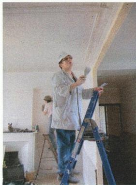
Recouvrement des espaces inter-poutres d'un mélange de terre et de paille.
